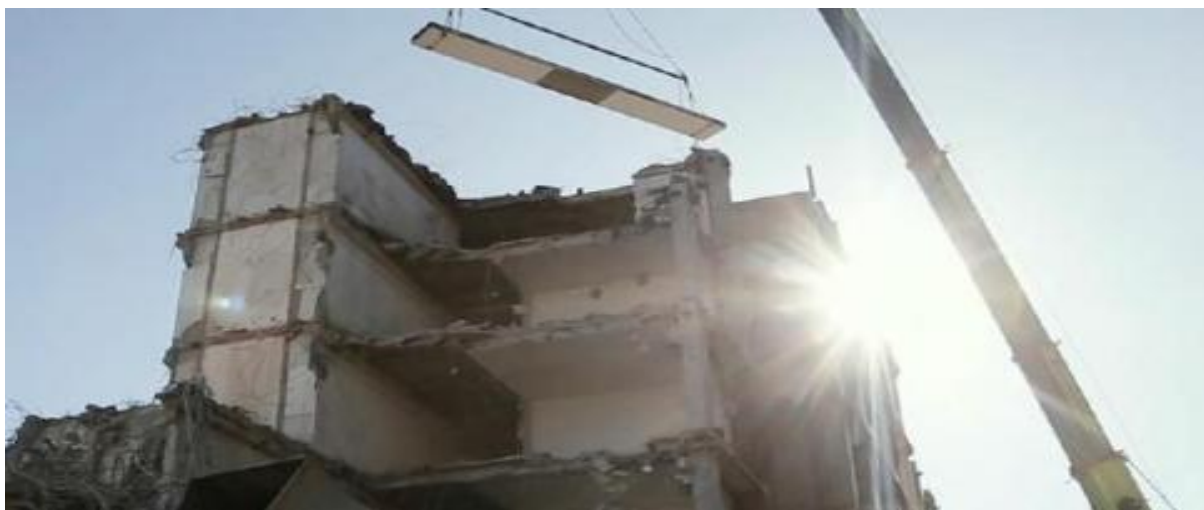
Skanska Norveška: betonski podi za večkratno uporabo.
